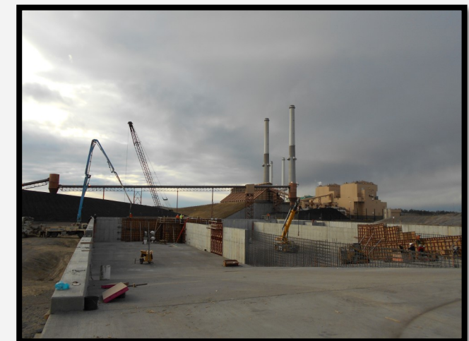
Sediment basin/clearwell wall pour.
