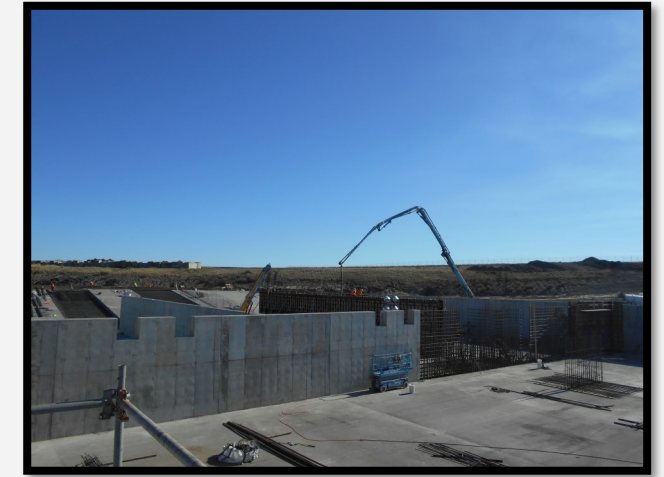
Sediment basin wall pour.
